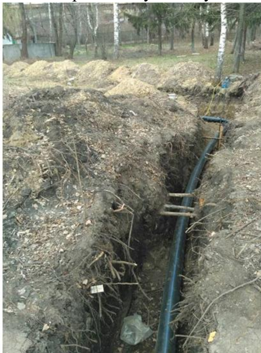
реконструкція водопровідної мережі
