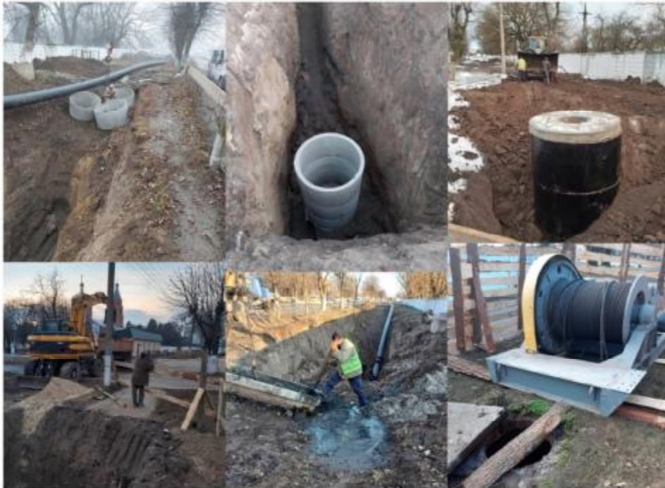
Підприємством ТОВ «Альфа -газ» проведені роботи по реконструкції трьох ділянок каналізаційного колектора по вул. Миру довжиною 255
